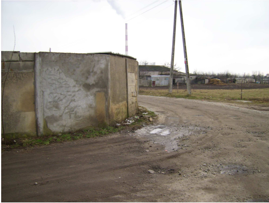
Fot. 1. Połączenie z istniejącą drogą gruntową w km około 0+115,00 – brak widoczności.
