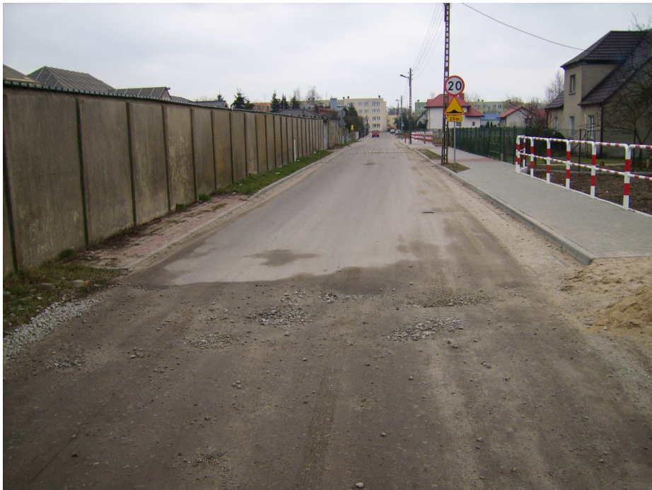
Fot. 2. Przekrój ul. Polnej – miejsce styku poszczególnych etapów budowy.
