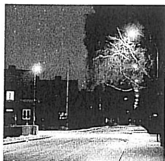
Jet 1 Źródło światła: 1 x 70W HST ULOR: 0,74 DLOR: 0,76 Wysokość zawieszania: 1m
