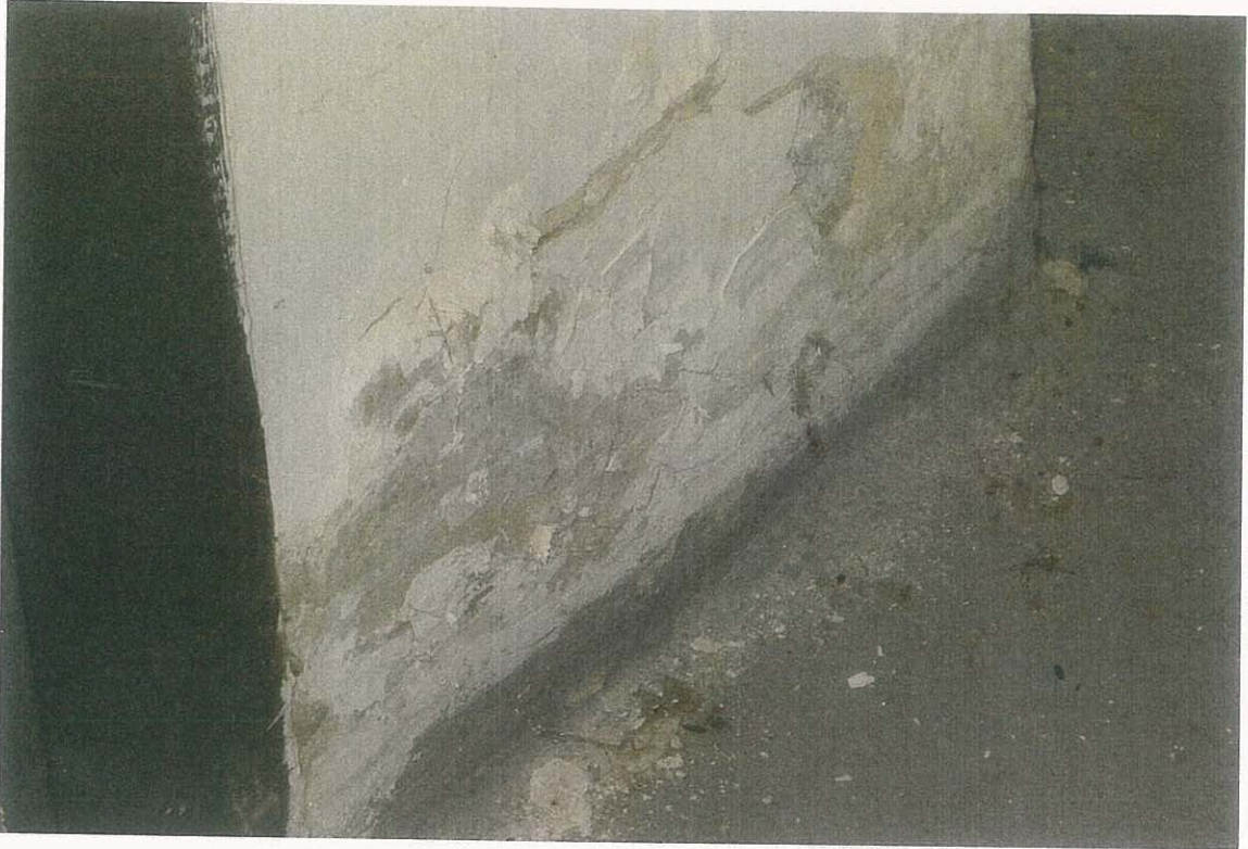
Fot. nr 31. Zawilgocona ściana zewnętrzna zach. przy wejściu zewnętrznym do pomieszczenia dawnej kotłowni.
