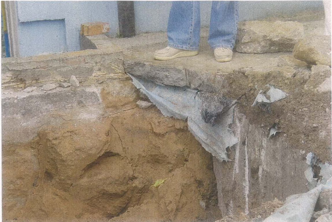
Fot. nr 5. Odkrywka przy świetliku odsłaniające zamurowane wejścia do kotłowni. Obok widoczny fragment starego fundamentu pod komin. Na ścianie świetlika brak izolacji pionowej.
