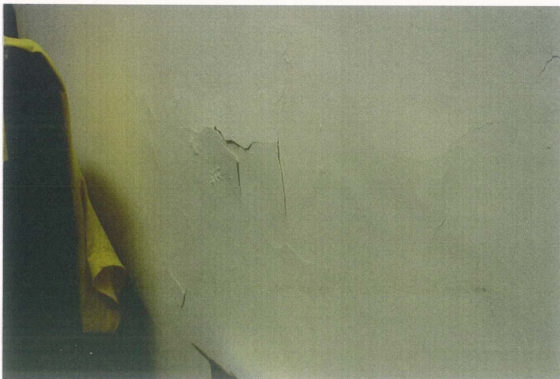
Fot. nr 24. ściana do klatki schodowej w pokoju sprzątaczek.
