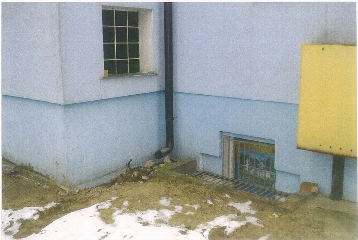
Fot. nr 6. Widok rury spustowej zakończonej kolankiem, odprowadzającym wodę opadową pod ściany piwnic.
