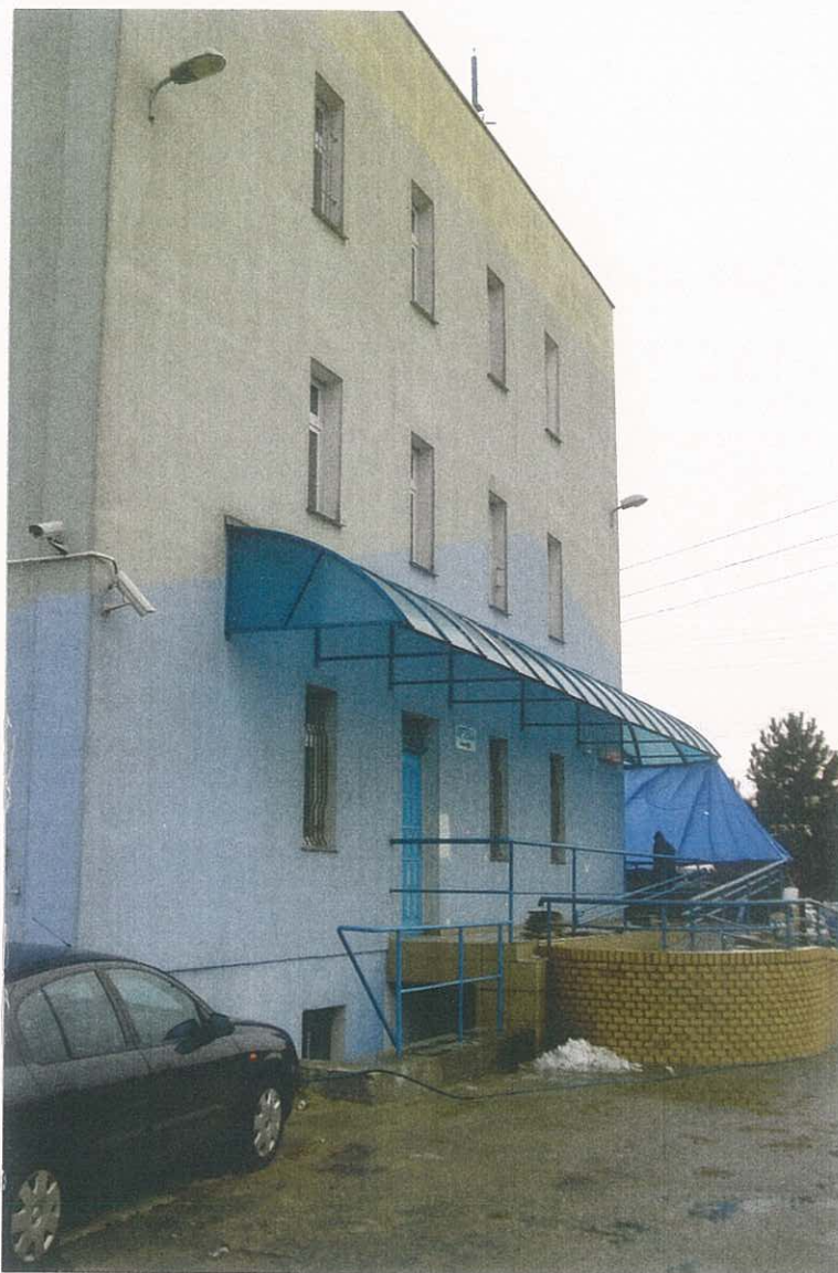
Fot. nr 2. Elewacja zachodnia z zadaszeniem wejściem do kotłowni oraz pochylnia dla osób niepełnosprawnych umożliwiająca wejście tych osób do budynku od strony frontowej –południowej
